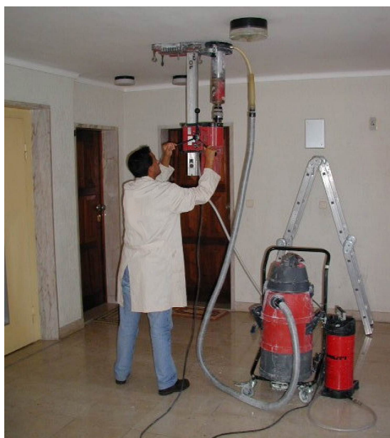
Fig.2 - Extracção de carote numa laje de um edifício.
